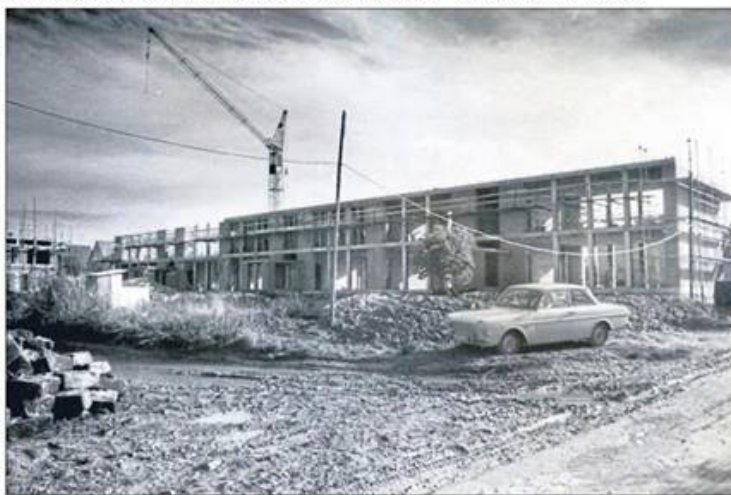
Baustelle: 1967 wurde die Freiherr-vom-Stein-Schule fertig gebaut. Vor dem Rohbau steht ein Ford 12M.
