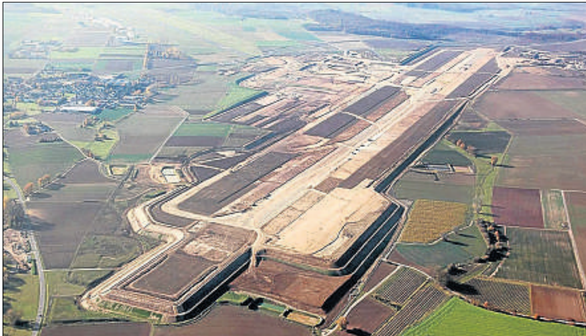
Gewaltige Ausmaße: Aus der Luft ist der neue Flughafen Kassel-Calden schon recht gut zu erkennen. Die Start- und Landebahn ist 2500 Meter lang und 45 Meter breit. Luftbild: Flughafen Kassel-Calden GmbH/Baunataler Filmproduktion Hans Haas
