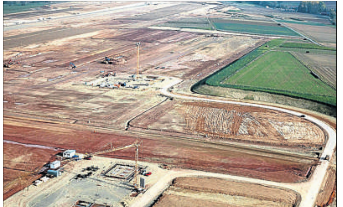
Es geht voran: Auf der riesigen Flughafen-Baustelle stehen jetzt Krane für die Hochbauten. Vorn im Bild entsteht das Terminal, hinten der Tower. Foto: Herzog/Charterflug Kassel
