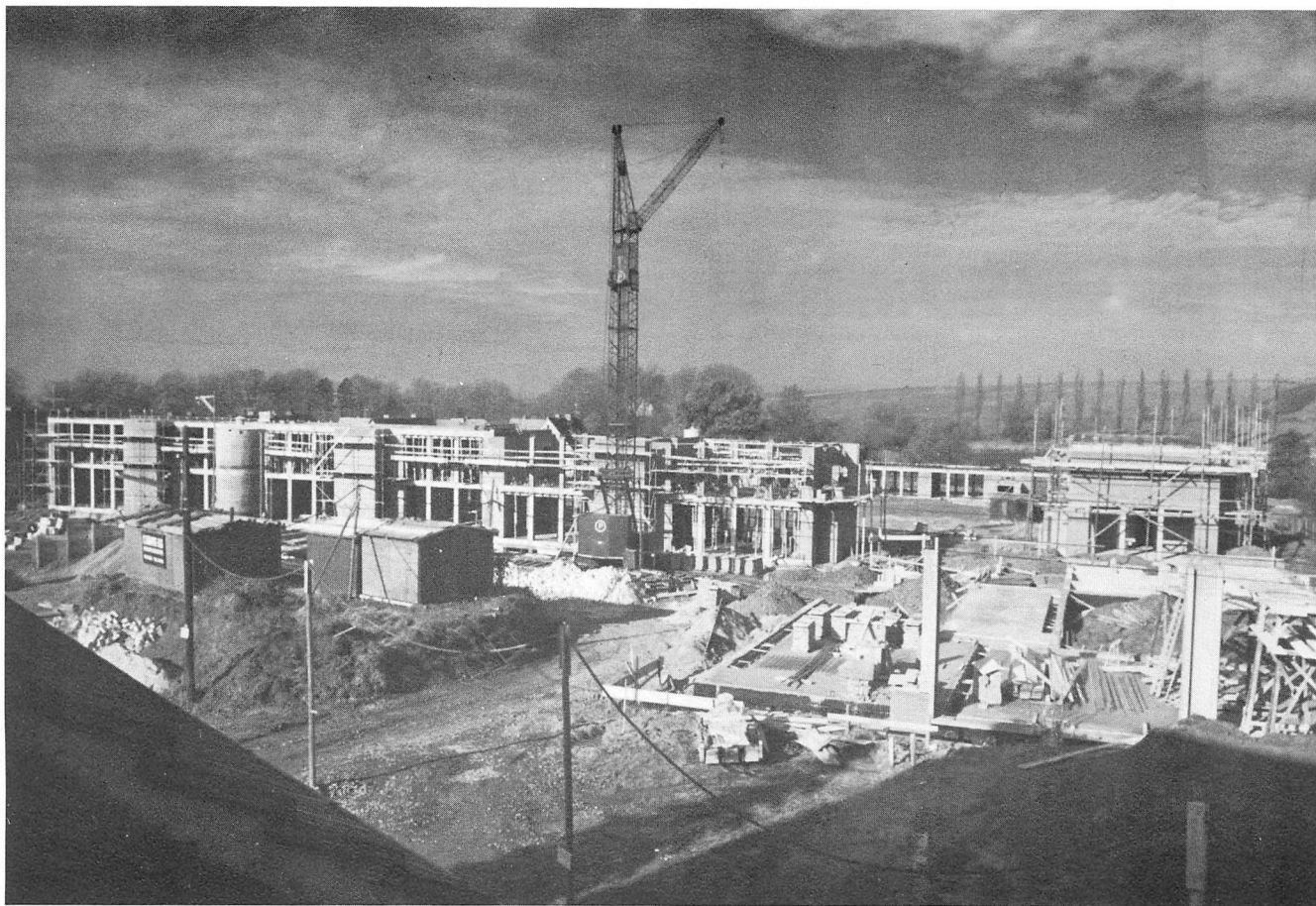
Neubau der Mittelpunktschule Baugelände am Kampweg 1965
